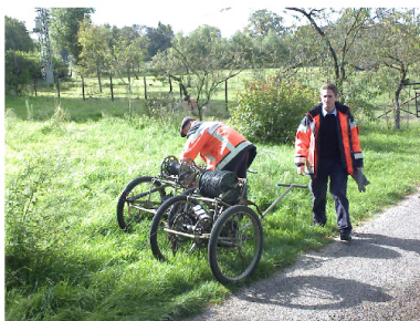
Kabelbau FmD Viersen
